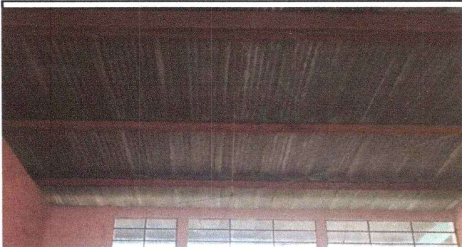
Foto 3: CABLEADO DEL SISTEMA ELECTRICO EN MAL ESTADO, NECESITA SER REPARADOS.
